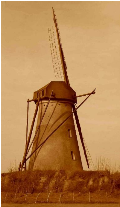
De herstelde molen te Calmpthout. De nieuwe roeden werden van een collega" te Esschen afgenomen.
