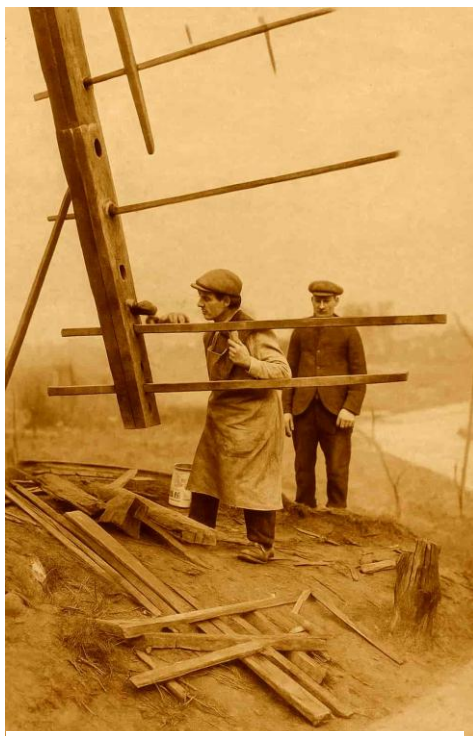
Het herstellingswerk in vollen gang. Het oude vermolmde gedeelte der roede wordt vervangen door jong,
